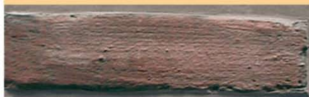
3- Lorsque la brique est trop abîmée (comme sur le cas 1), le badigeon à la chaux peut la protéger, tout en respectant ses qualités esthétiques (sa forme, sa couleur, son appareillage).
