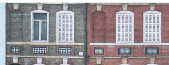
Le badigeon de chaux doit s'appliquer dans le respect des matériaux de façade.
