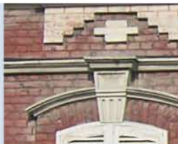
Éliminer les efflorescences superficielles par nettoyage doux.
