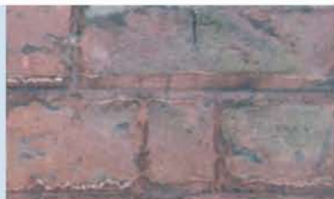
Joint beurré en ton sur ton, repassé au fer.
