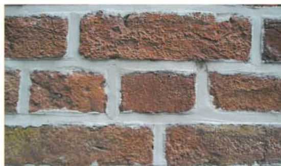
1- La brique de cette maçonnerie a été endommagée : son épiderme est grêlée. Un nettoyage inadapté en est la cause, sans doute un sablage trop agressif.
