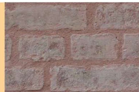
2- Ci-dessus, l'épiderme de la brique a été préservée. la brique a été débarrassée du voile gris de la pollution tout en conservant ses qualités esthétiques et techniques.
