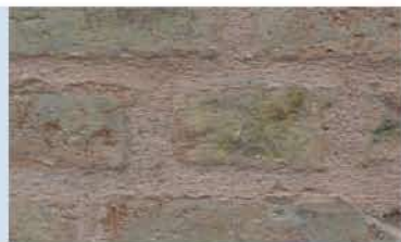
Joint plein en ton sur ton.
