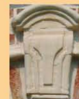
4- Ici, les détails sculptés de cette clef de fenêtre ont été plus ou moins effacés suite à un nettoyage trop abrasif.
